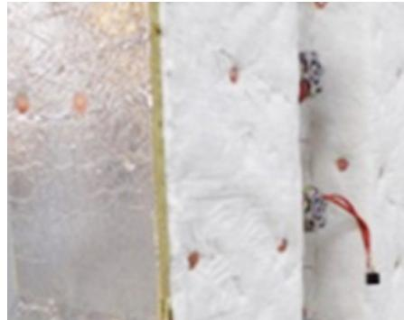
**L'isolation** du caisson arrière est assurée par 2 couches de laine de verre Aiguilène de 38 mm et d'un panneau de laine de verre revêtement alu de 25 mm. Sur le caisson avant, 2 panneaux de laine de roche sont posés croisés en rupture de pont thermique : parfaite conservation de la chaleur et régularité de cuisson garanties !
